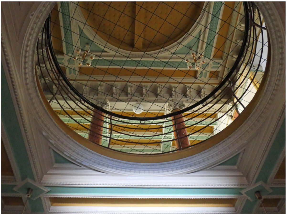
Blick vom Treppenaufgang nach oben | Foto: Ralf Meisel, September 2023
